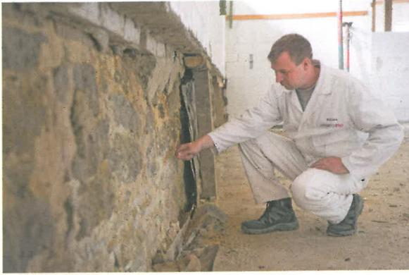
Begutachtung des vormals von einer Bitumenbahn abgedeckten Kalksandsteinmauerwerks der Scheune
